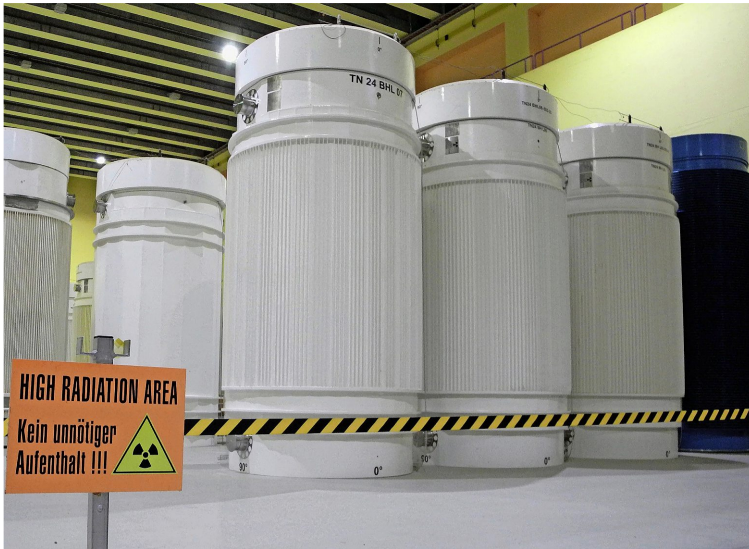
Blick ins Zwischenlager (Zwilag) im aargauischen Würenlingen mit den Lagerbehältern (Castoren) für hoch radioaktive Abfälle: Bis das Endlager gebaut ist, lagert der strahlende Abfall in einer Halle direkt an der Aare. Foto: Kurt Tschan
